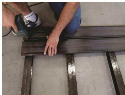
Figura 8 - Fixação final do grampo.
