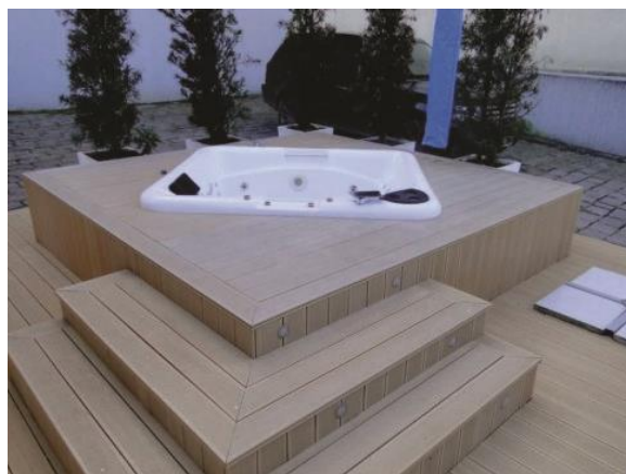
Figura 11 - Arremate com barras
