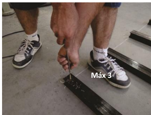
Figura 4 - Fixação do barrote com parafuso de (6 x 80) mm. Distância entre barrotes máxima de 30 cm.
