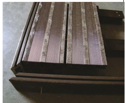
Figura 13 - Arremate lateral via fixação no barrote de 8 cm.
