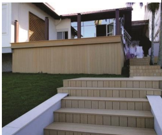
Figura 10 - Arremate com barras
