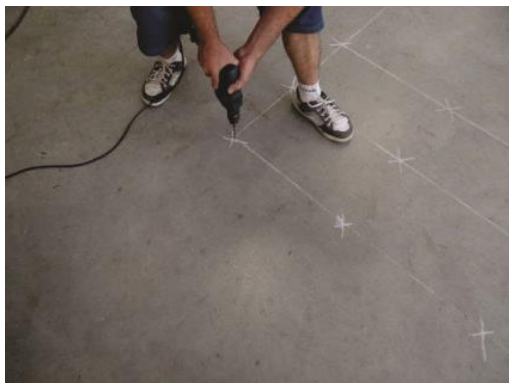
Figura 1 - Marcação do piso e furação com broca de 8 mm. m
