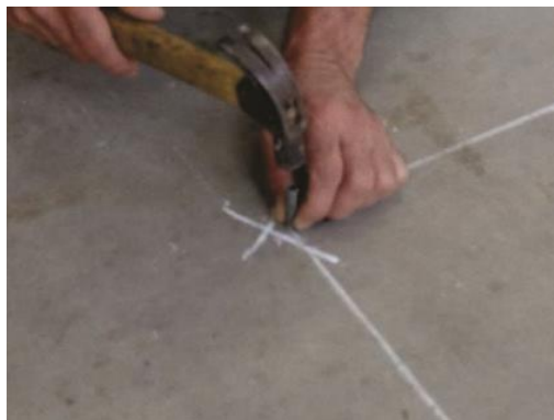
Figura 2 – Colocação da bucha de 8 mm no piso.
