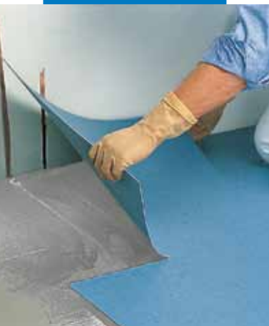
Assentamento de quadrados em PVC condutivo com Ultrabond Eco V4 SP Conductive
