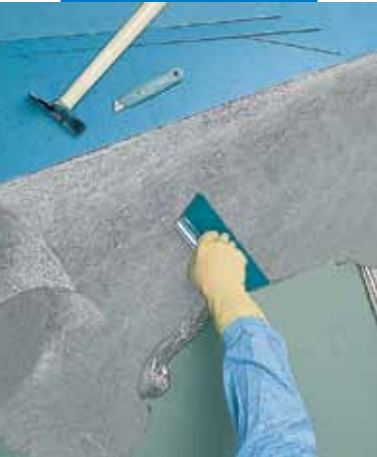
Aplicação de Ultrabond Eco V4 SP Conductive
